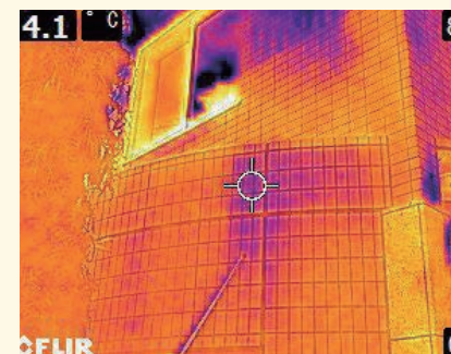
赤外線サーモグラフィー
