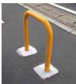
バリカー設置
